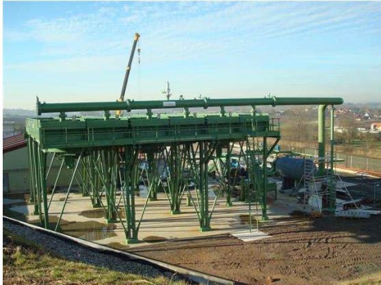
Figure 4 : Installation du système de refroidissement par air.
